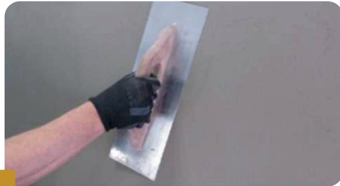
Fot.2 VYHLADZOVANIE CELKU ŠIROKÝM HLADIDLOM SO ZACHOVANÍM HRÚBKYVRSTVY
