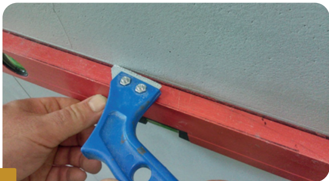
Fot.5 VYREZÁVANIE IMITÁCIE SPOJOV BETÓNOVÝCH DOSIEK POMOCOU ŠKRABKY NA ŠKÁRY
