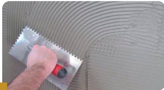
Fot.1 ROVNOMERNÉ NANÁŠANIE BOLIX TBR ZUBOVÝM HLADIDLOM S ROZMERMÍ ZUBOV 6 MM
