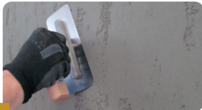
Fot.4. POUŽITIE BENÁTSKEHO HLADIDLA PO ÚVODNOM VYTVRDNUTÍ PRE DOSIAHNUTIE HLADKÉHO POVRCHU
