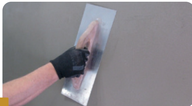
Fot.2 VYHLADZOVANIE CELEJ PLOCHY ŠIROKÝM HLADIDLOM, ZACHOVÁVAJÚC ROVNOMERNÚ HRÚBKU VRSTVY
