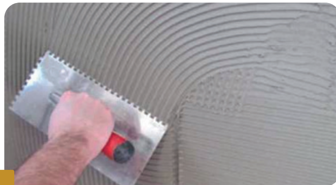
Fot.1 ROVNOMERNÉ NANÁŠANIE BOLIX TBR POMOCOU ZUBOVÉHO HLADIDLA S ROZMĚRI ZUBOV 10x106 MM
