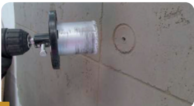
Fot.7 KORUNKOVÝ VRTÁK NA ZHOTOVENIE IMITÁCIE SPOJOVACÍCH PRVKOV DEBNENIA
