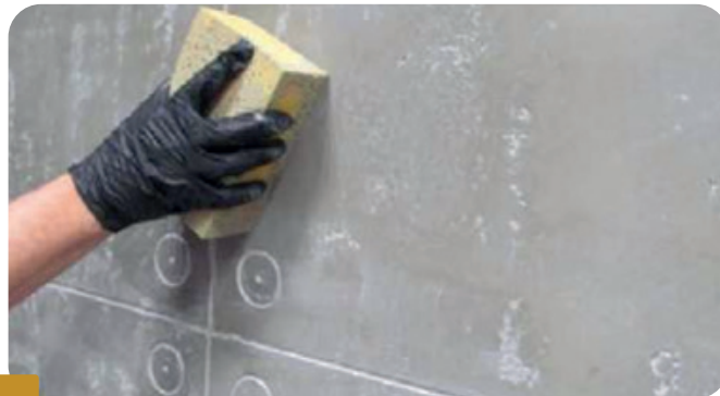
Fot.8 APLIKÁCIA BOLIX DECO LAZUR POMOCOU VHLKEJ ŠPONGIE
