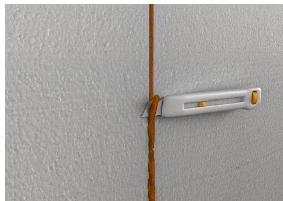
Fot.17 Odstraňovanie nadbytočného množstva vytvrdnutej nízkoexpanznej peny.
