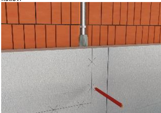
Fot.14 Zakreslenie vonkajších rozvodov na tepelnoizolačných doskách.
