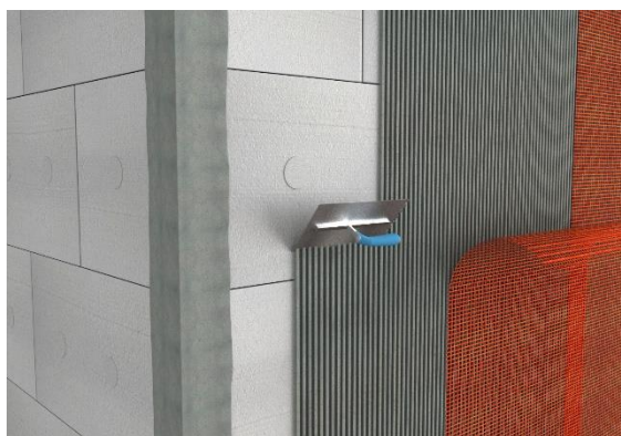
Fot.33 Nanášanie lepiacej malty na tepelnoizolačné dosky.
