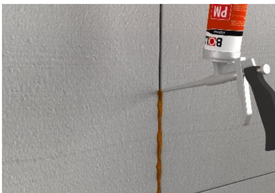
Fot.16 Vyplňanie škár medzi polystyrénovými doskami nízkoexpanznou penou.
